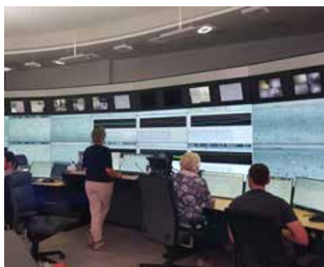
Die neue Leitwarte bei der MVL.
