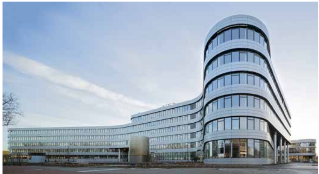
Hauptverwaltung der RheinEnergie in Köln-Ehrenfeld.
