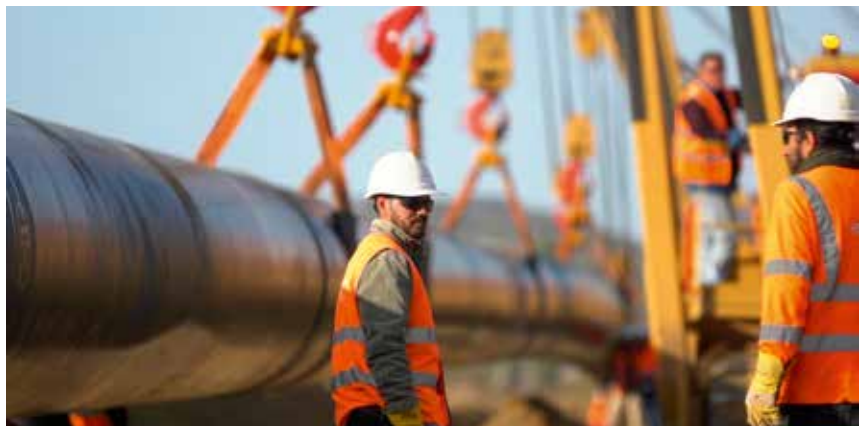
Bautätigkeiten in Nordgriechenland, November 2016.
